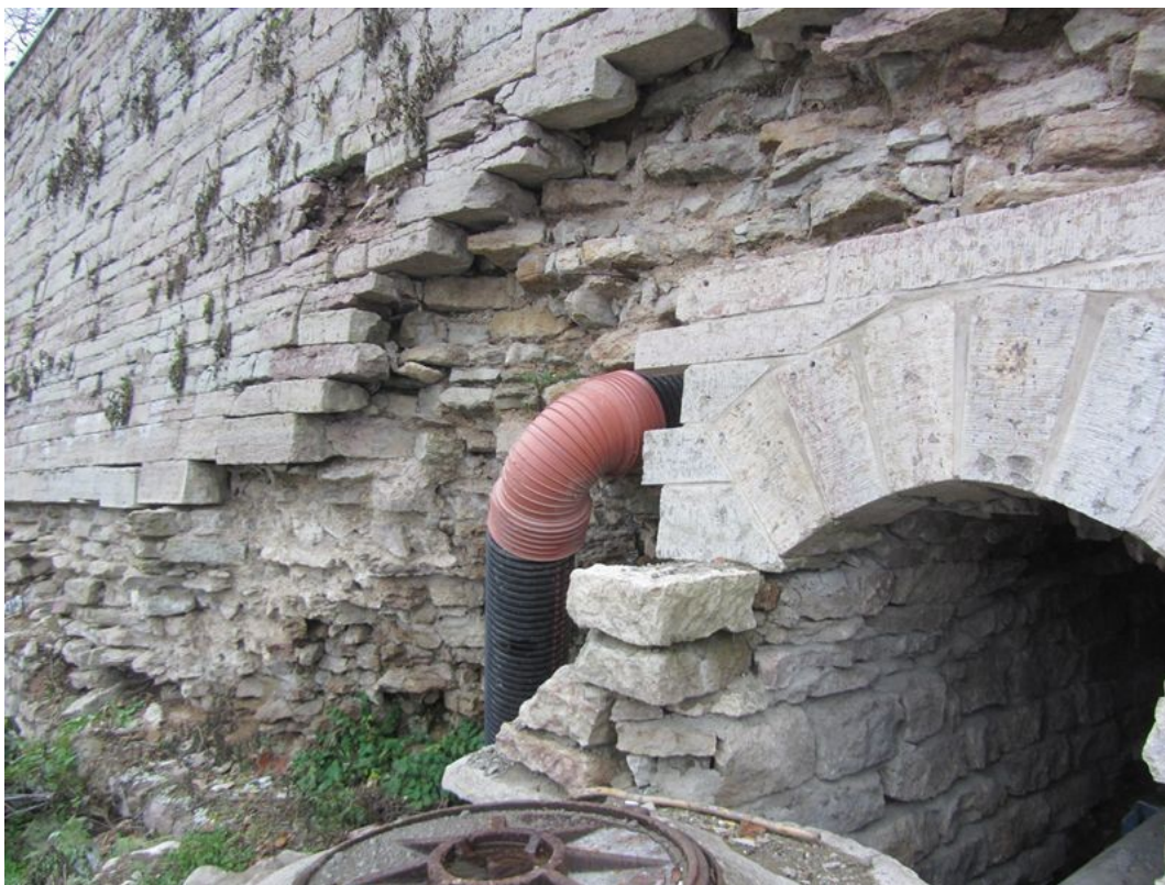
Foto 7. Justitia bastioni poolse vihmaveeäravoolu ava kahjustused osa.
