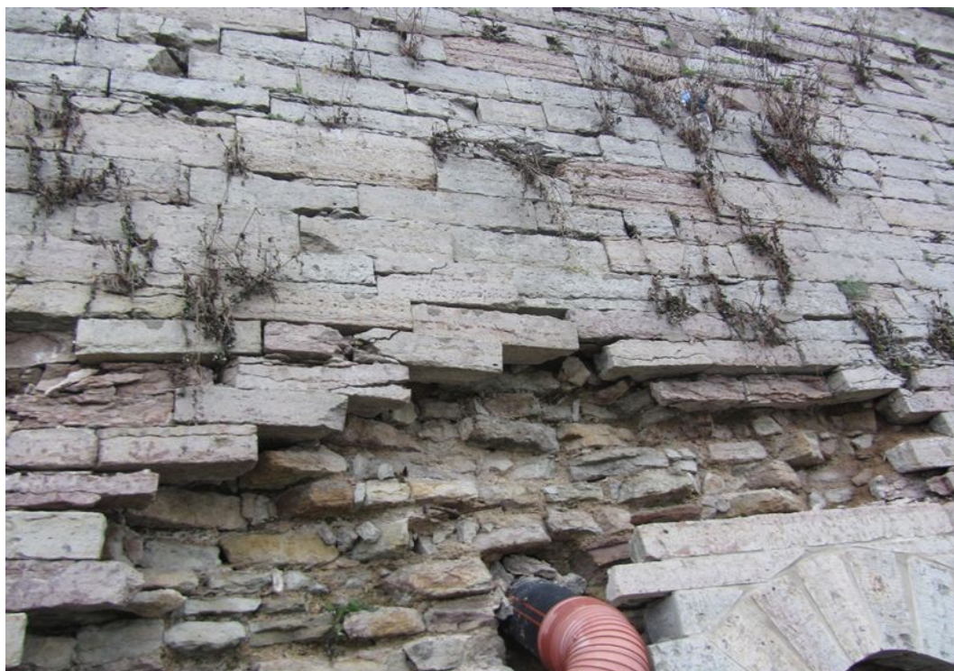
Foto 8. Drenaažitoru kohal olev varisemisohtlik vooder.
