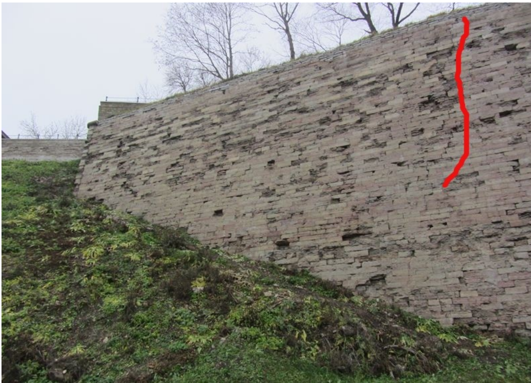
Foto 3. Vaade Pax bastioni kagufaasi lõunapoolsele osale. Foto paremas servas on punasest joones vasakul vertikaalne pragu.
