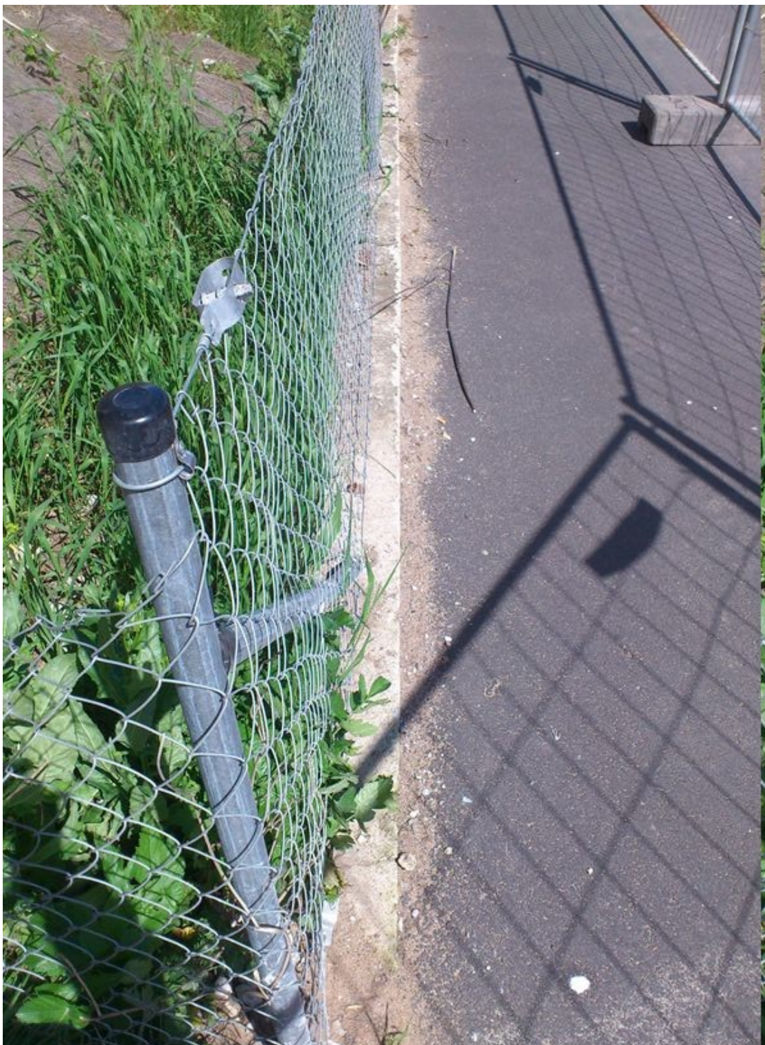
Foto 8. Vaade olemasolevale võrkaiale.
